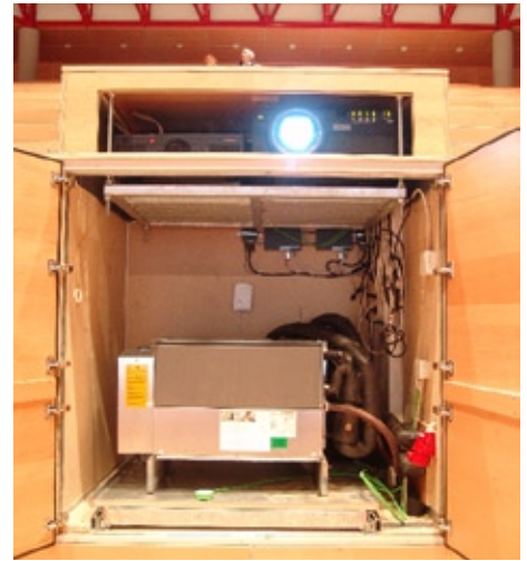
Projektionsaufbau mit zwei Panasonic-Projektoren, Kühlung und QuickMedia-Anschlüssen
