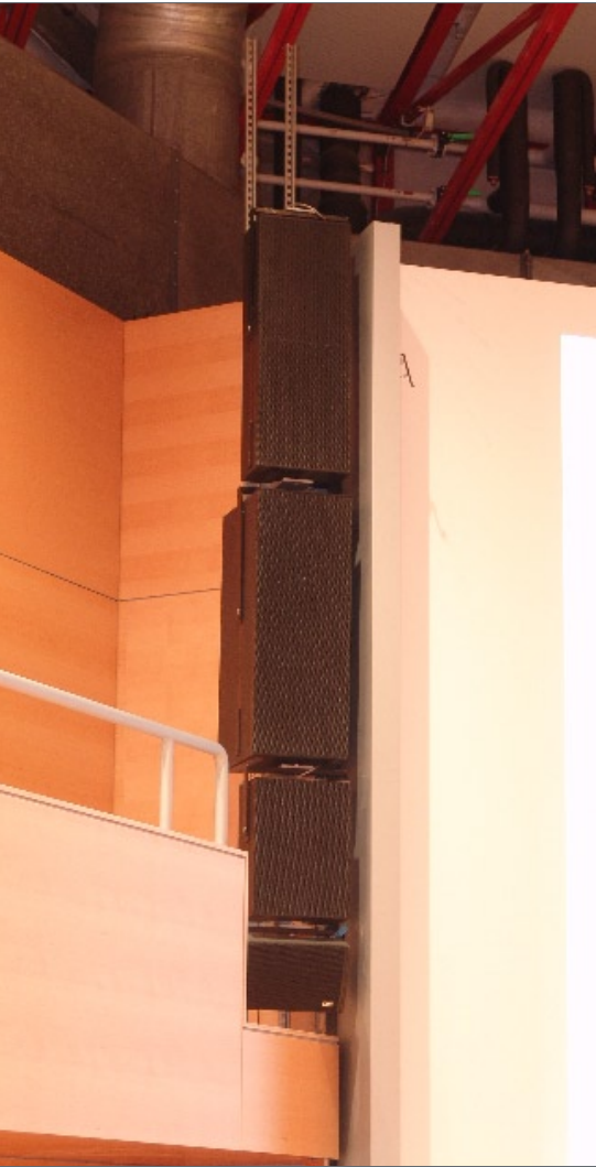
Hauptbeschallung Alcons Audio Q-Serie
