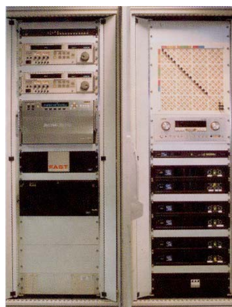
Gestellschränke im Regieraum: Ganz links u.a. die Synapse-SDI-Wandler (türkise Frontplatte) mit Patchfeld, rechts daneben die Network-SDI- (blau) und Komtech-RGBHV-Kreuschienen. Im Bild rechts u.a. der DVCPRO-Videoserver und Zuspiele, sowie rechts davon ein Audiorack.
