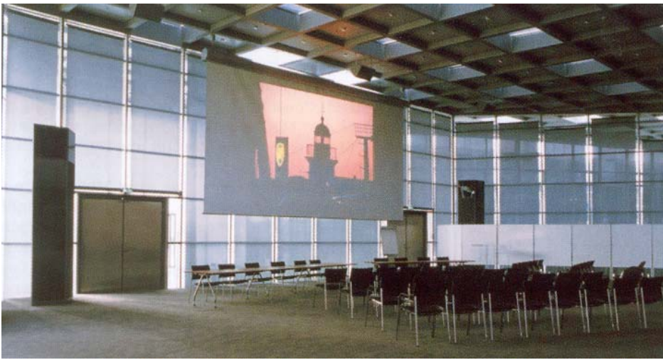
Großer Konferenzsaal. In den Säulen neben der Leinwand sind die IR-Strahler und die Subwoofer untergebracht.
