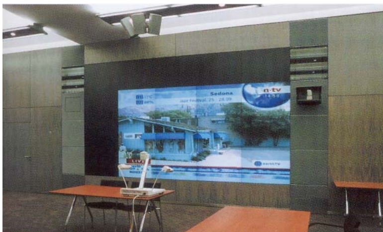
Rückprojektions-Cubewand im Konferenzraum des Communication Centers. Bildgröße und Seitenverhältnis können dem Signalformat angepaßt werden. In diesem Bild sind 12 von insgesamt 20 Cubes im Betrieb.
