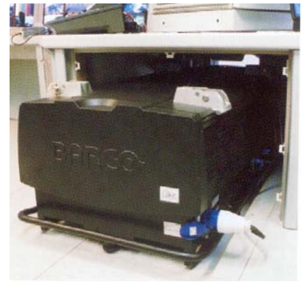
Die beiden Barco-Projektoren für den großen Konferenzsaal sind über eine Art Schubladenauszug von der Regie aus bequem zugänglich.
