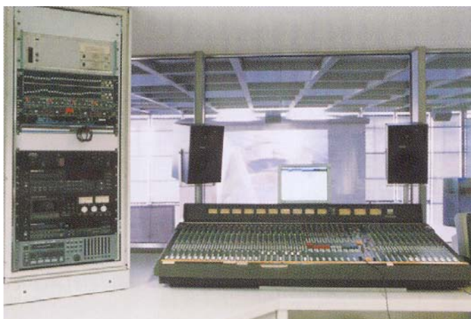
Blick in die Regie des großen Konferenzsaals. Links das Tonmischpult mit Abhörlautsprechern und Zuspielrack.
